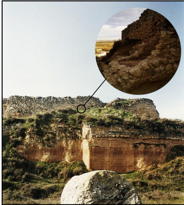
Figura 4. Lienzo de la muralla ente el Portillo y la Puerta de San Juan. Se aprecian los restos de una torre.
